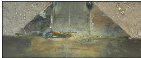
Figura 5.59. Suelda en soporte de Neumáticos de Emergencia.
