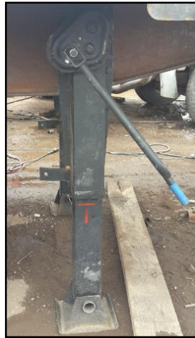
Figura 5.46. Patín de poyo instalado.
