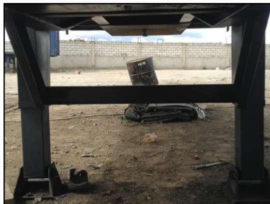
Figura 5.50. Perfil de seguridad entre patas y largueros de plataforma.
