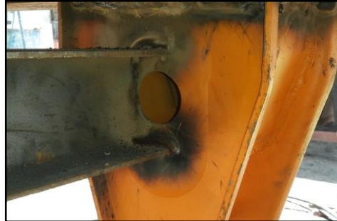
Figura 5.7. Suelda de travesaño en soporte delantero de suspensión.
