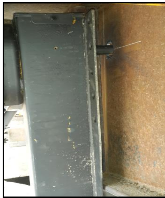
Figura 5.41. Pata de apoyo montada.
