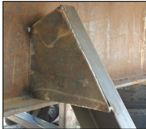
Figura 5.58. Punto de suelda en soporte de Neumáticos de Emergencia.
