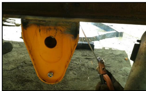
Figura 5.6. Cordón de suelda en soportes.
