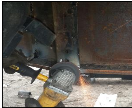
Figura 5.43. Esmerilado de los soportes.
