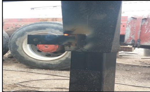
Figura 5.48. Soporte para perfil de seguridad.
