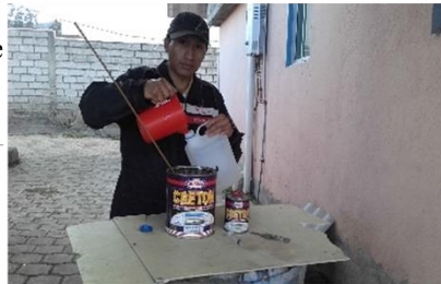
Preparación de la resina epoxi 30min
