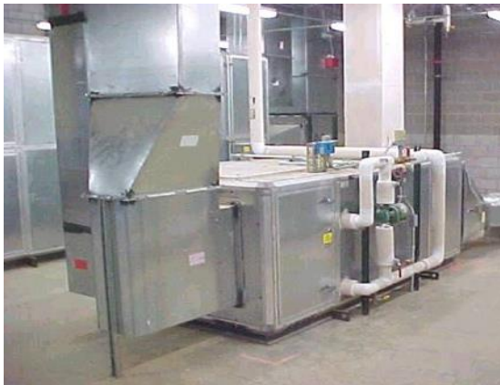
Sistema HVAC colectivo o central
