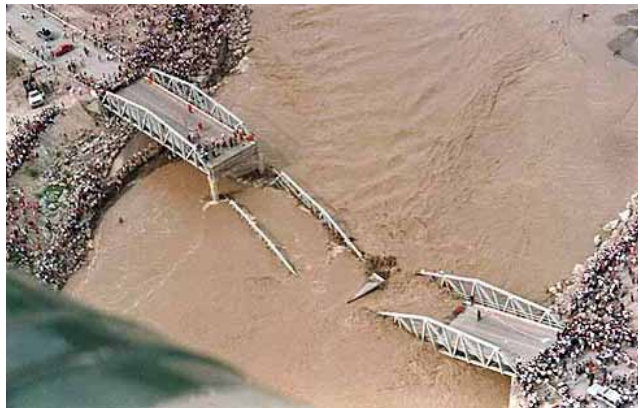
Fig. 2.26, Vulnerabilidad física: Puente Reque colapsado en Perú. De www.caretas.com.pe
