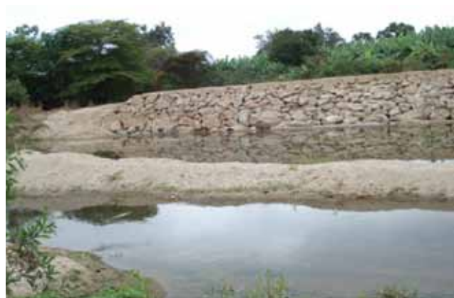
Fig. 1.108, Muros directores de gaviones, río Zarumilla. Carlos Gutierrez
