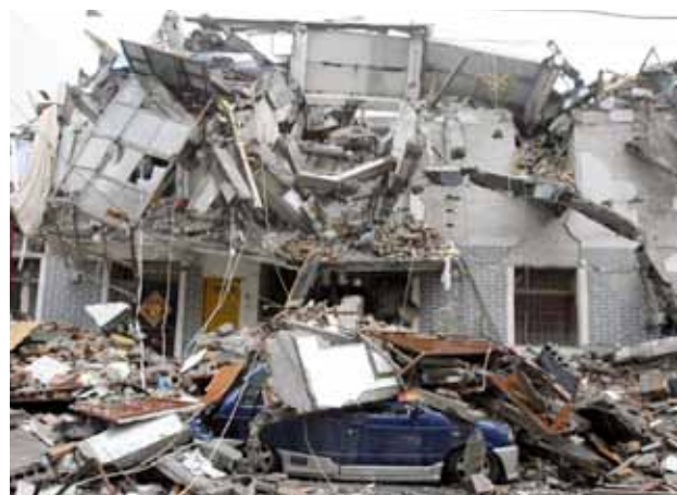
Fig. 1.15, Colapso de edificio por terremoto en China. AFP
