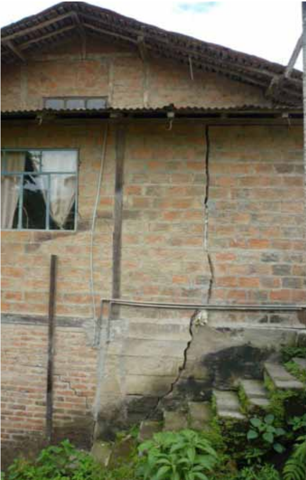
Fig. 1.16 - 1.17, Daños en casas y muros debido de fallas geológicas activas. Piñas, Ecuador . (GEO1-Toulkeridis)
