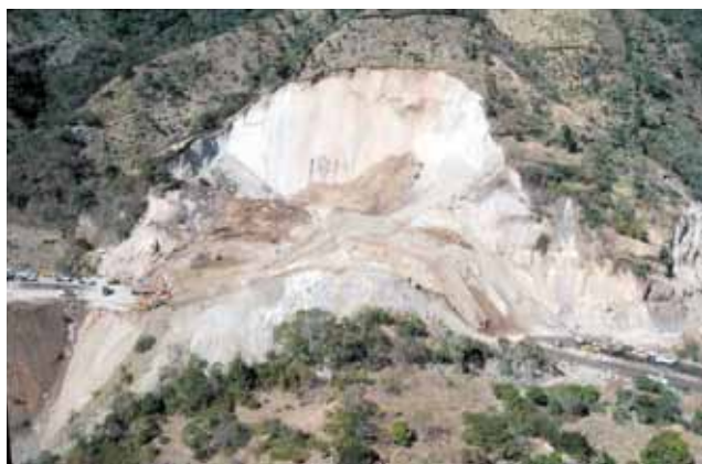
Fig 1.68, Deslizamientos interrumpiendo la actividad socio-económica devastando parte de una autopista en Ecuador. Cortesía Rafael Guardado.
