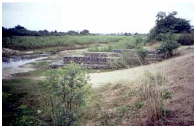
Fig. 1.107, Terraplenes de escollera, río Zarumilla Carlos Gutierrez
