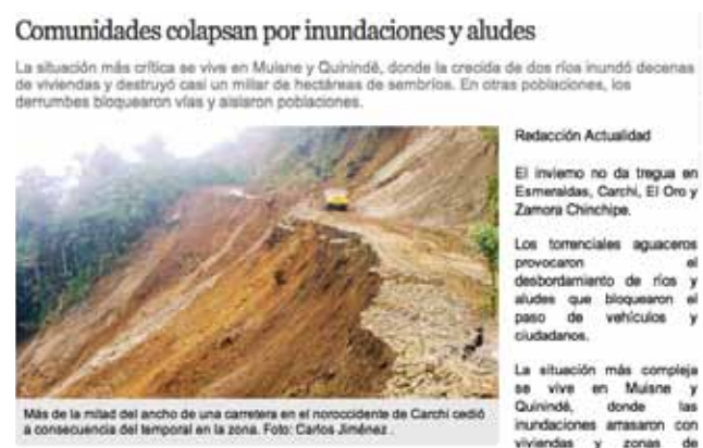
Fig. 2.66, Daño colateral debido a un deslizamiento. La Hora.
