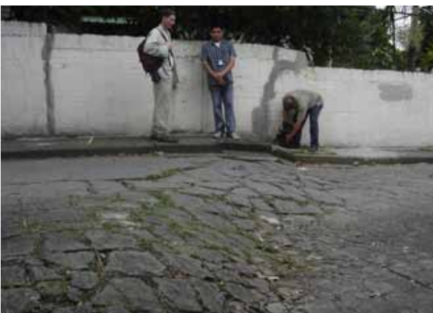
Fig. 1.18, Deformaciones en via debido de falla geologica activa, Manila, Filipinas. (GEO1-Toulkeridis)
