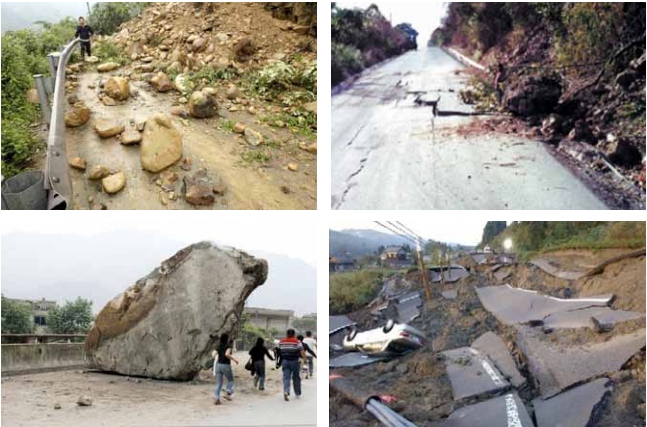
Fig. 1.82-3.95, Caída masiva (arriba izquierda, China 2008, Associated Press), parcial (arriba derecha, Ecuador 2005, El Hoy) o de gran tamaño (izquierda abajo, China 2008, Associated Press) de rocas. Derrumbe masivo (Japon, 2003, Associated Press)
