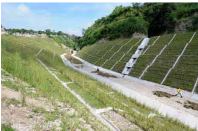
Fig. 2.10, Obra de mitigación exitosa: La cárcava en La Campanera. De skyscrapercity.com
