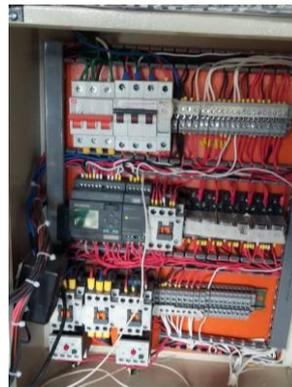
**Figura 4. 2. Tablero de control de la máquina**
