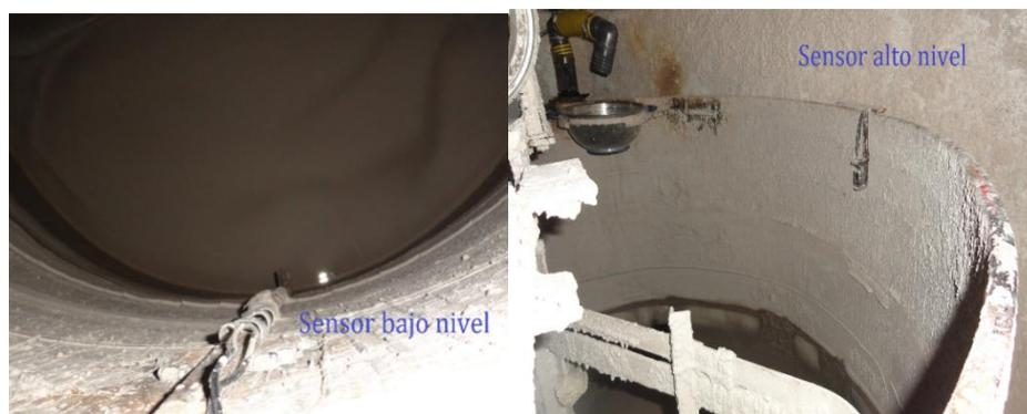
**Figura 3. 11. Sensores de nivel**
