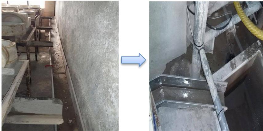
**Figura 3. 9. Montaje de las canaletas de recolección**
