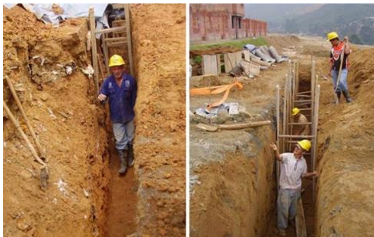
Figura 16. Excavación Manual
