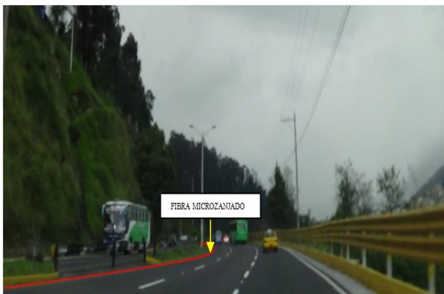
Figura 20. Tramo de tendido subterráneo de Fibra Óptica, tramo de Orquídeas – El Trébol_2
