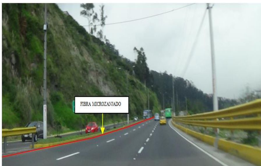
Figura 21. Tramo de tendido subterráneo de Fibra Óptica, tramo de Orquídeas – El Trébol.
