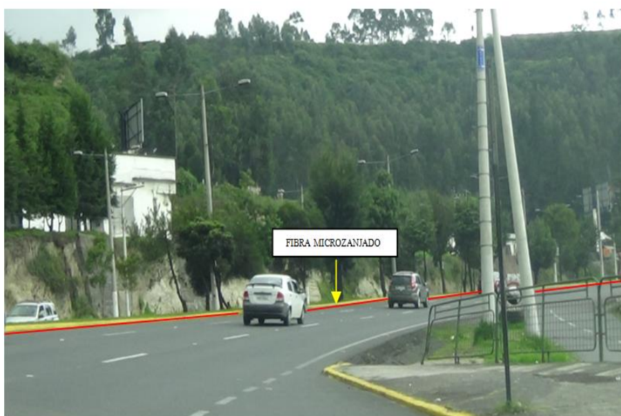
Figura 33. Tramo Puente 2 – Puente 3.
