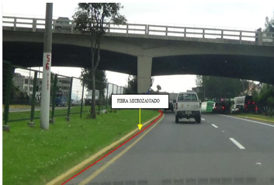
Figura 27. Tramo del sector el Peaje, puente nueva Vía Oriental.
