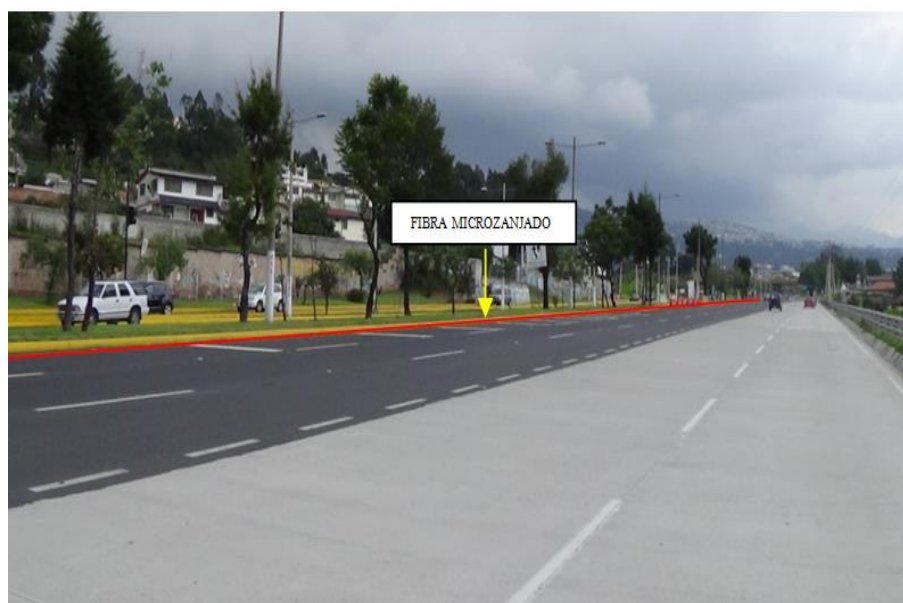
Figura 43. Tramo Puente 8 – Puente 9.
