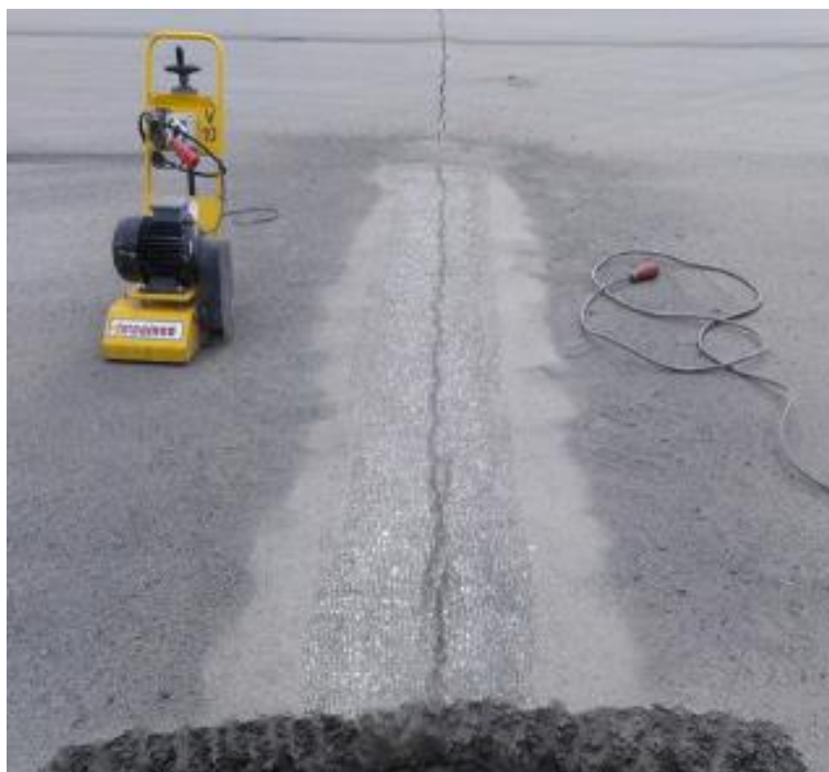
Figura 17. Corte de asfalto con amoladora.
