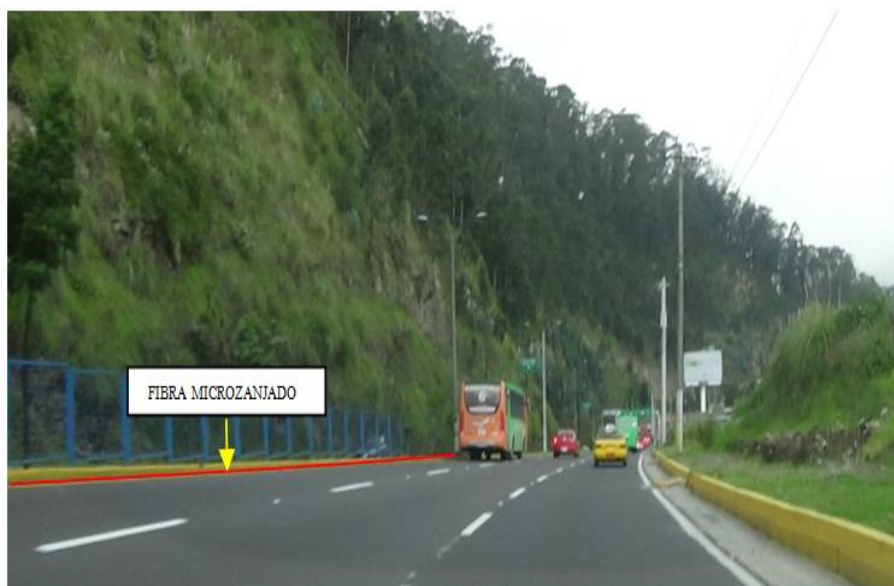
Figura 19. Tramo de tendido subterráneo de Fibra Óptica, tramo de Orquídeas – El Trébol.
