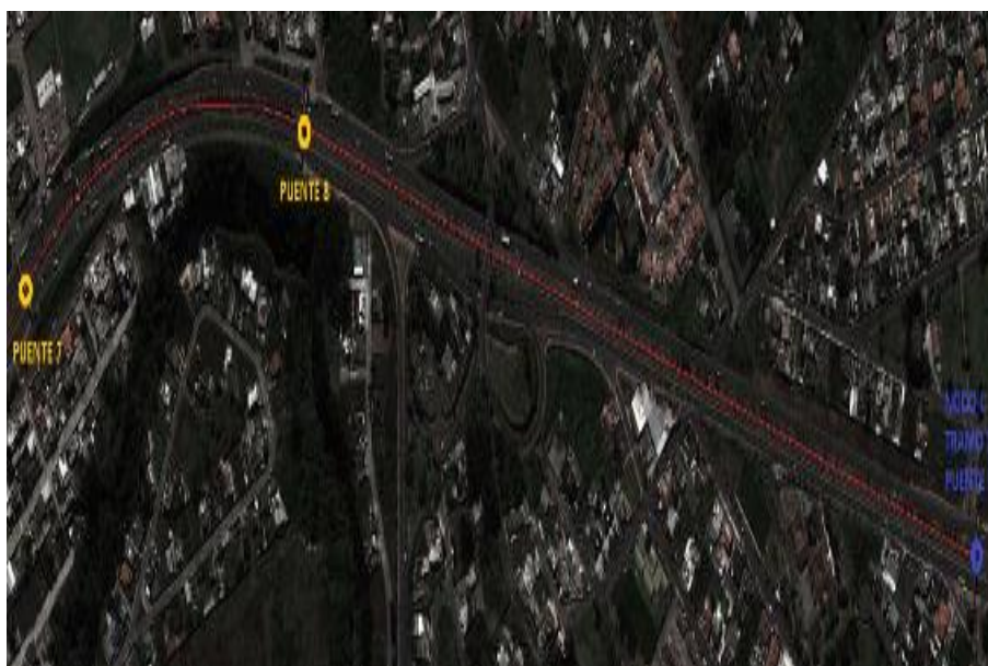
Figura 52. Enlace de fibra Puente 7 – Puente 9
