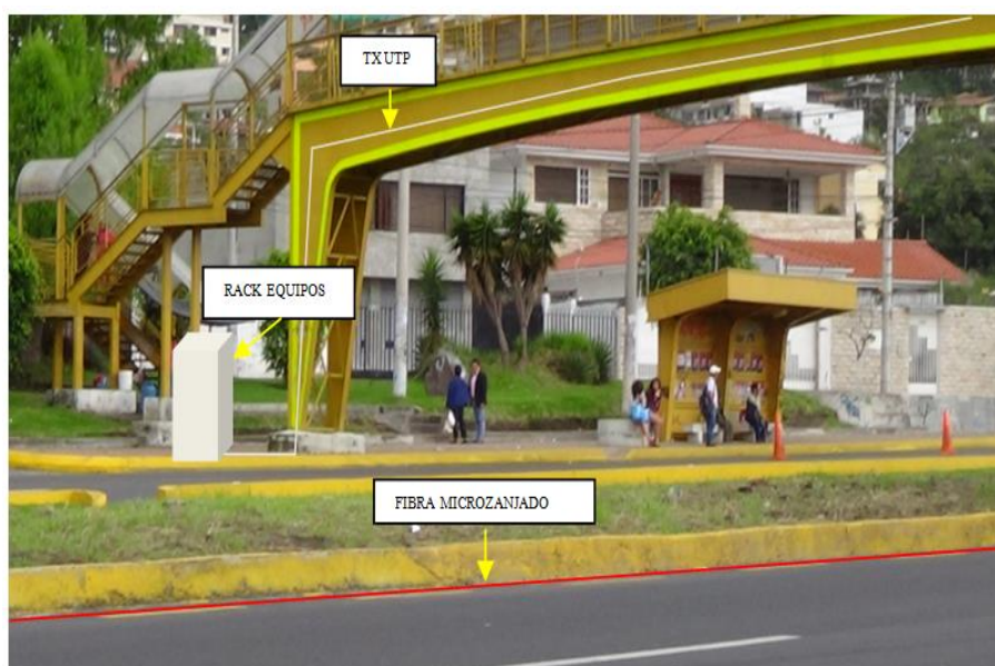
Figura 44. Ubicación del cuarto de equipos en el Puente 9.
