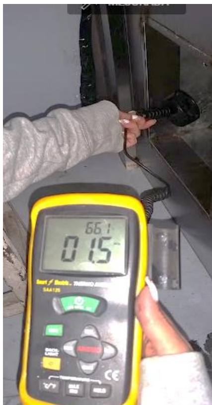
Figura 207 Medición Velocidad de Aire de Ingreso a la cámara de secado
