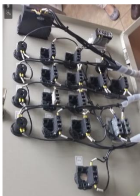
Figura 196 Amarras plásticas y canaletas flexibles para el cableado
