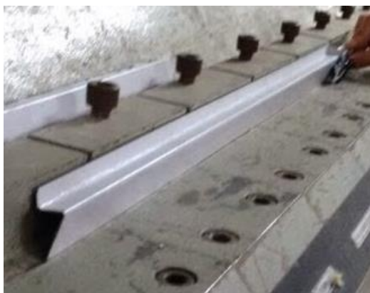
Figura 159 Perfil de soporte lateral de bandejas
