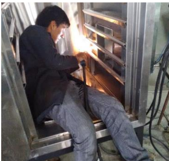
Figura 160 Soldadura de perfiles de soporte de bandejas
