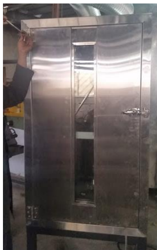
Figura 163 Instalación de bisagras de la puerta
