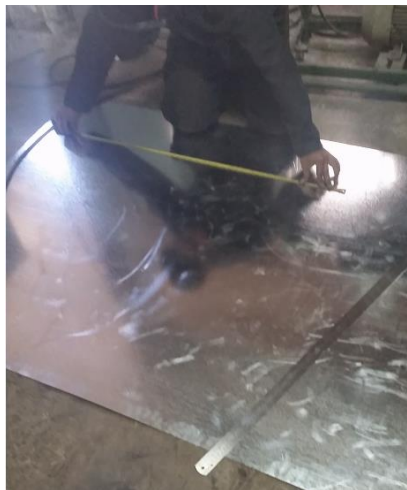
Figura 130 Medición y trazado de aristas y límites en láminas de acero galvanizado (externo) y acero inoxidable (interno)
