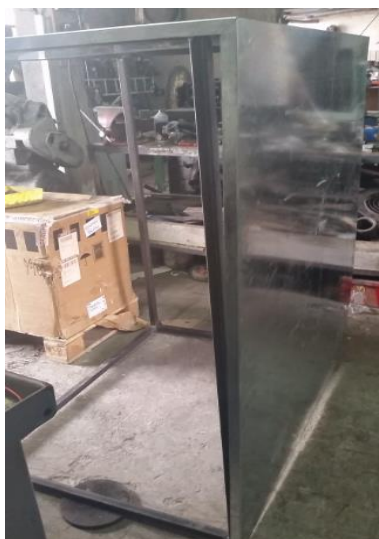
Figura 133 Colocación de lámina exterior sobre la estructura de la cámara
