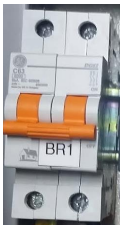
Figura 181 Interruptor termomagnético GE de 2 polos, 63A, 220 V
