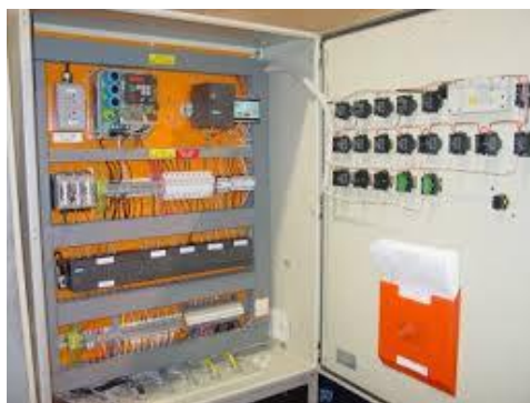
Figura 6 Montaje de sensores y actuadores en tablero de control
