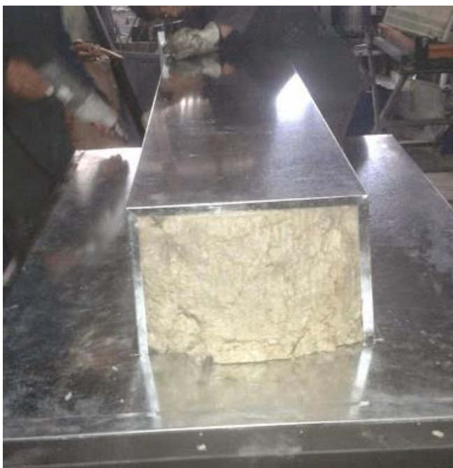
Figura 152 Recubrimiento de ducto externo
