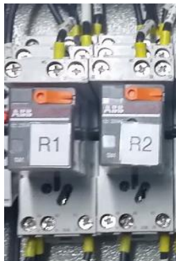
Figura 191 Relé ABB 2P, 30 A
