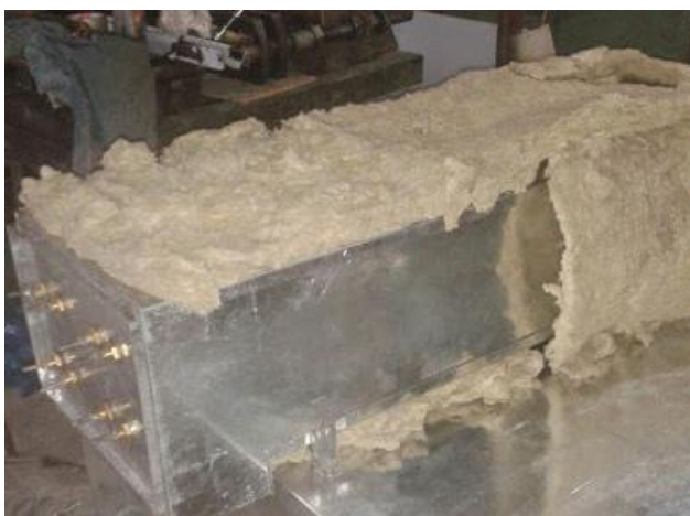
Figura 151 Recubrimiento del ducto interno con aislante
