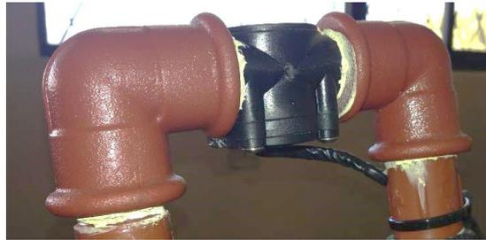
Figura 87 Sensor de flujo YF-S201 instalado
