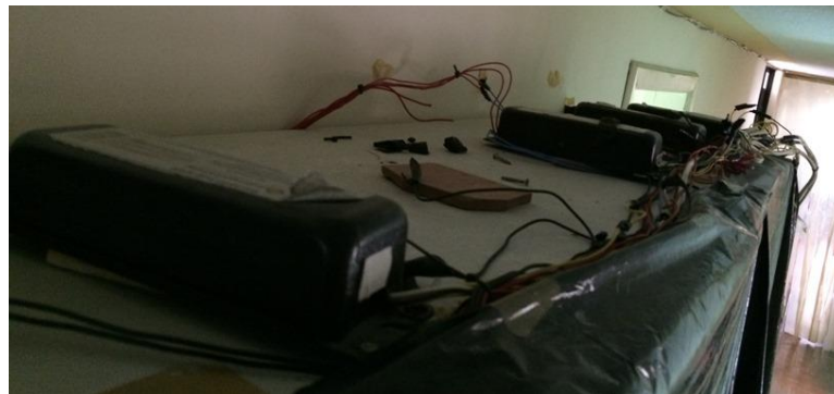
Figura 8. Balastos para Encendido de Lámparas Fluorescentes.
