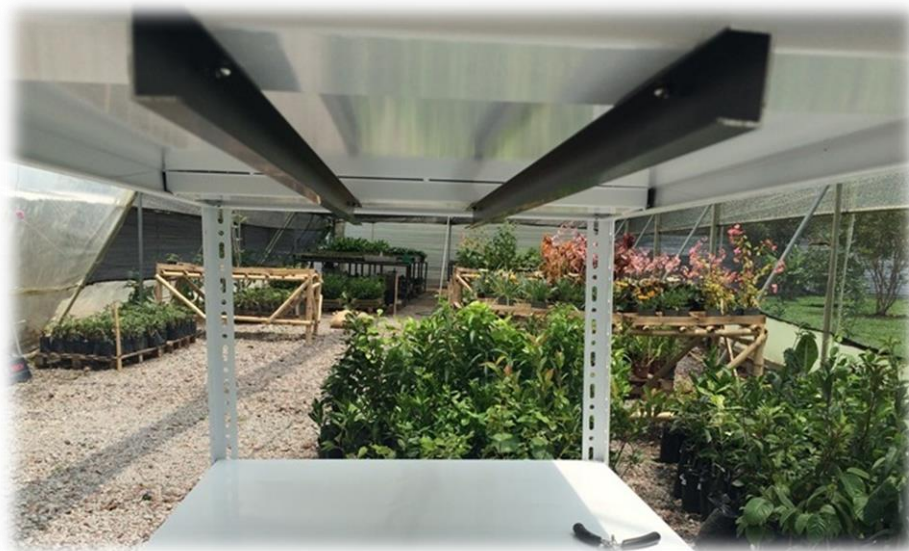
Figura 22. Colocación de Rieles Para Lámparas LED.
