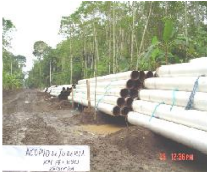
Figura 7.9 Almacenamiento de la tubería
