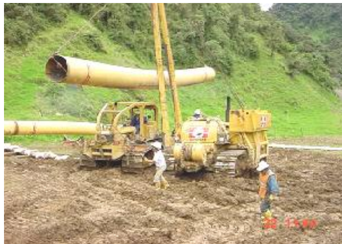
Figura 7.10 Manejo de tubería
