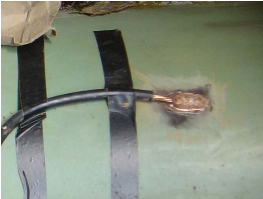
Figura 5.8 Soldadura Cadweld (1)
