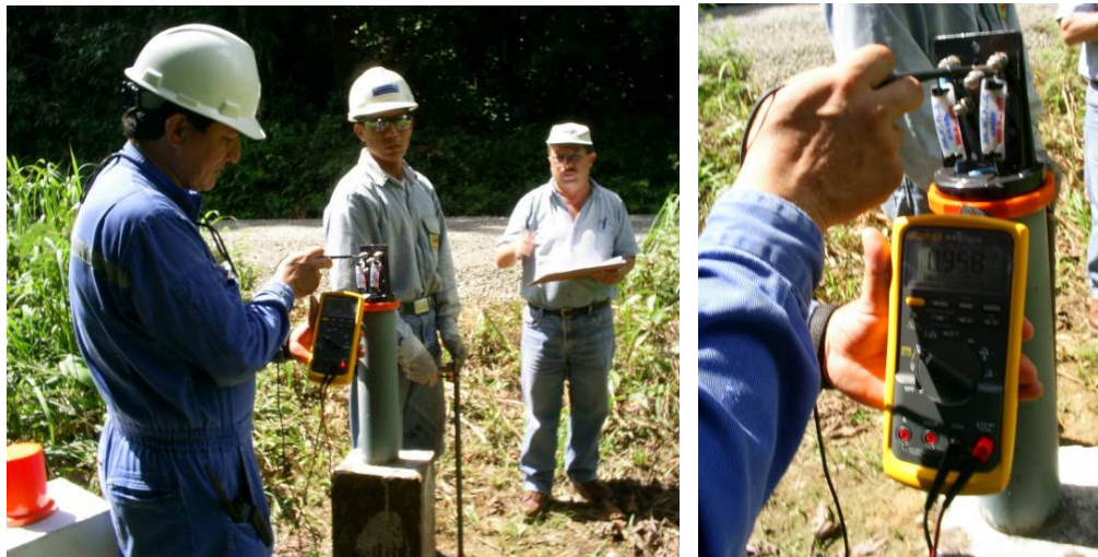
Figura 2.17 Medición de potencial en postes de prueba (1)
