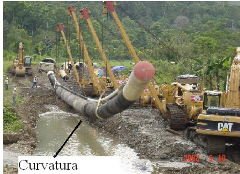
Figura 7.7 Curva fabricada en campo
