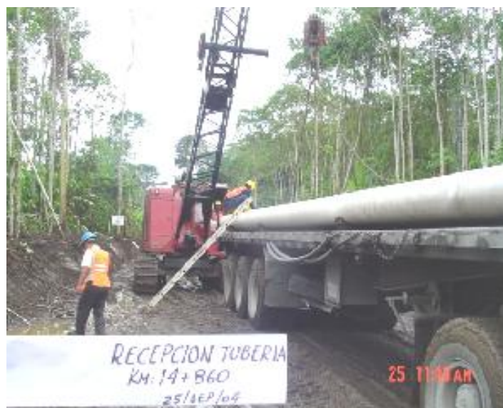
Figura 7.8 Transporte de tubería
