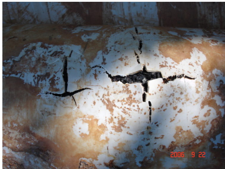
Figura 3.22 Revestimientos protectores de tuberías enterradas (2)
