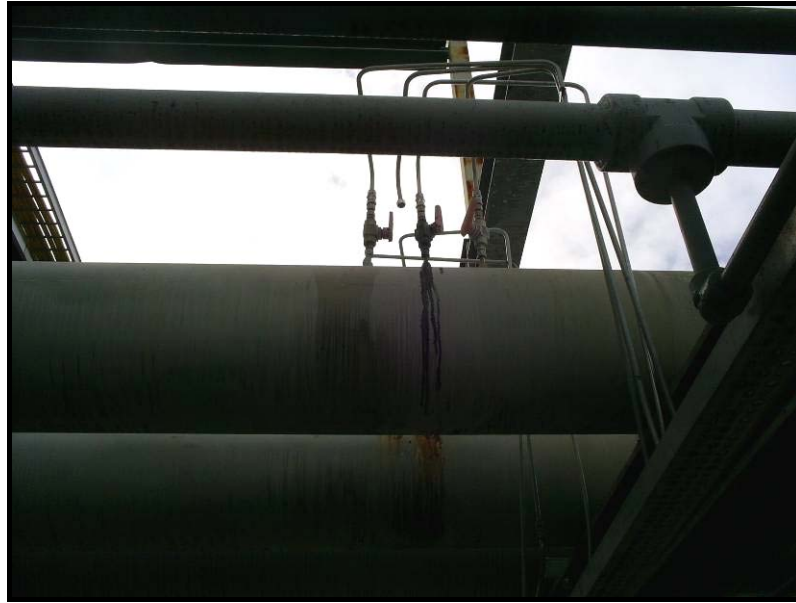
Figura 2.5 Tubería principal crudo planta – Tubings para inyección de químicos
