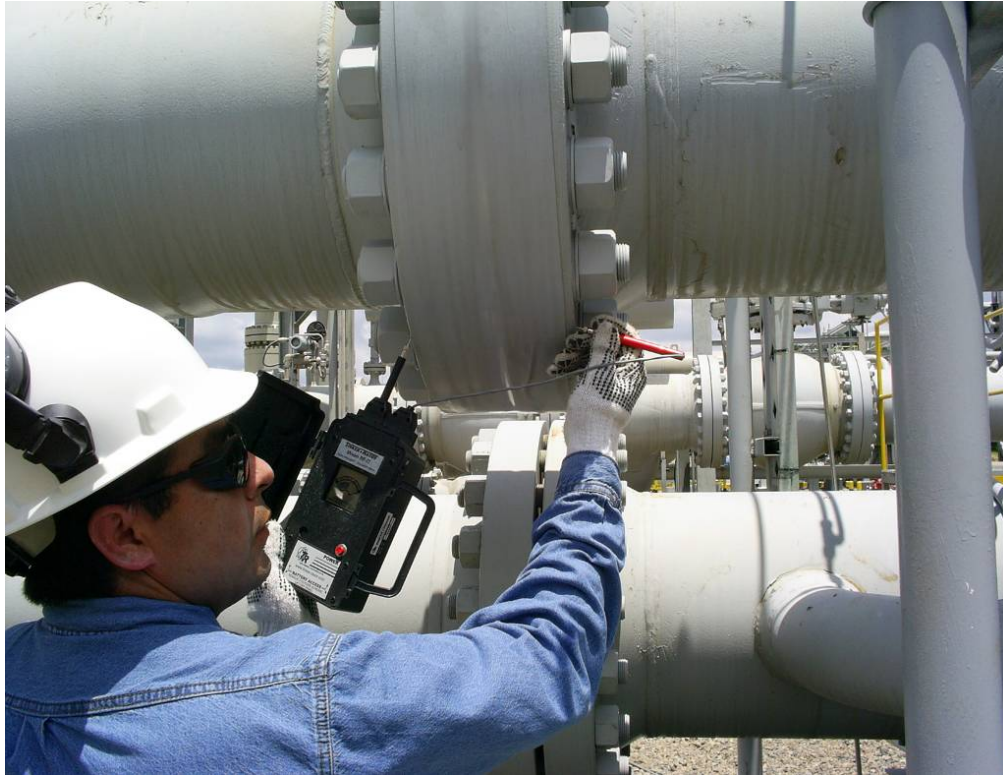
Figura 2.35 Medición de eficiencia en juntas aislantes (2)
