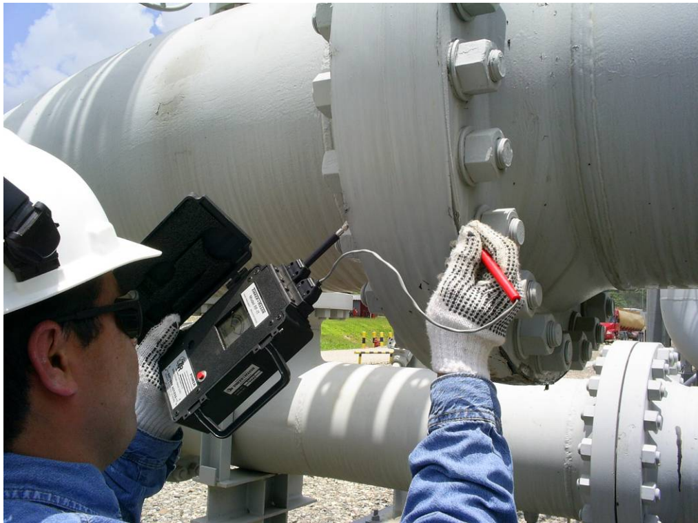
Figura 2.34 Medición de eficiencia en juntas aislantes (1)
