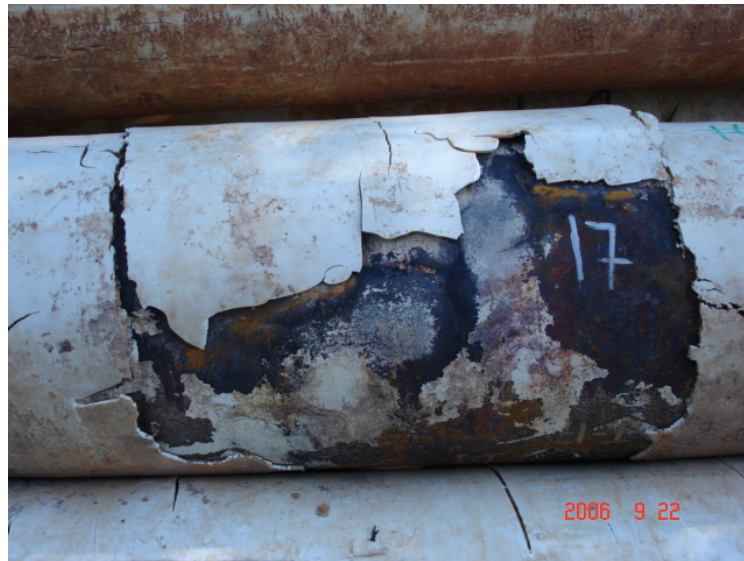
Figura 3.21 Revestimientos protectores de tuberías enterradas (1)
