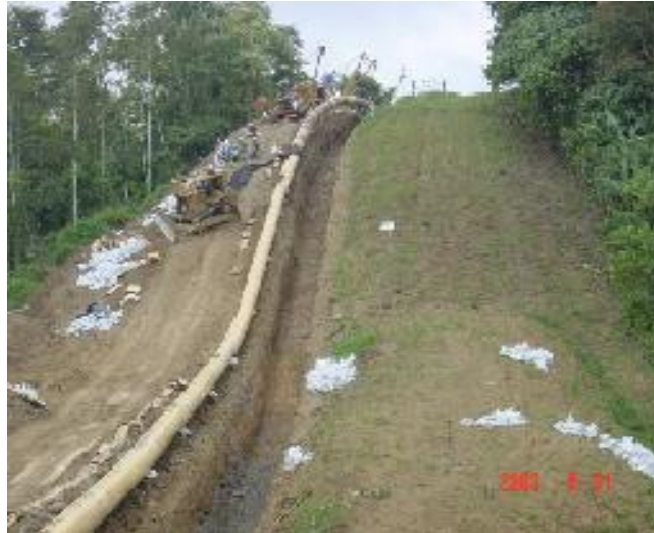
Figura 7.11 Zanjado para tubería
