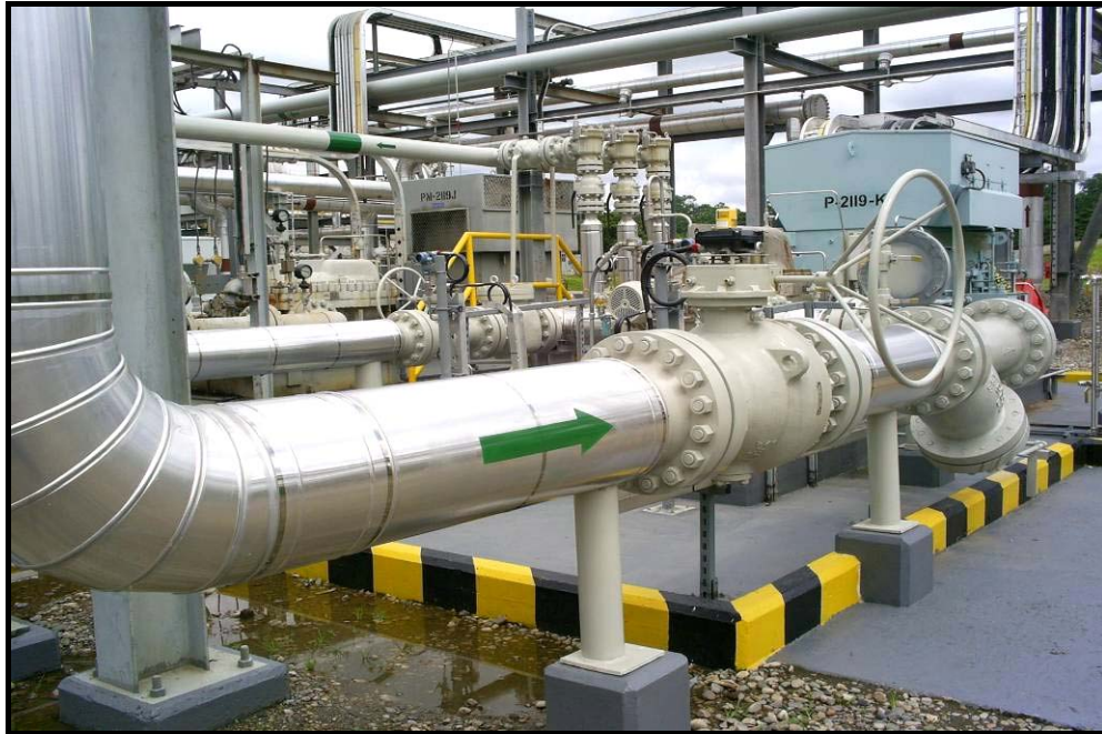
Figura 2.9 Bombas de alta presión
