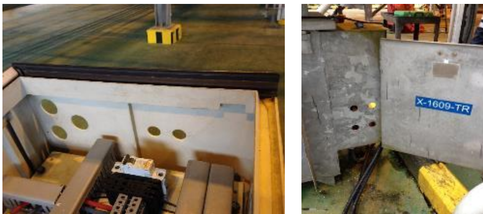
Figura 57: Orificios para Conectores TMCX y HUBS.
