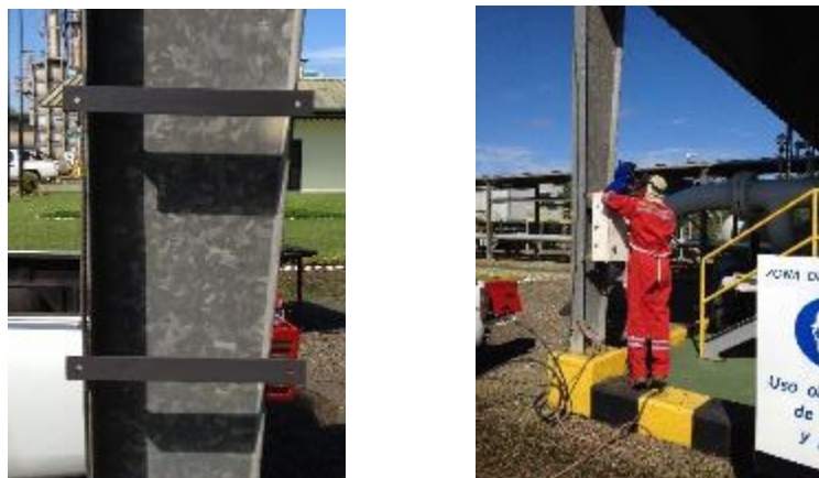
Figura 56: Soldadura Soportes Tablero Eléctrico.
