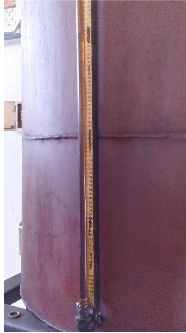
FIGURA N° 78 Visualización del Nivel de Diesel con Manguera
