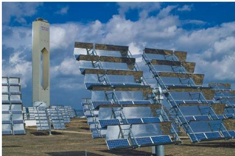
Figura 4. Sistema de Receptor central. Fuente: (Briceño, 2011).
