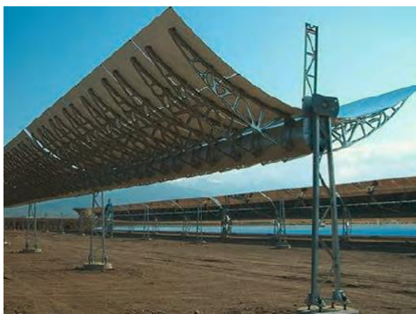
Figura 8. Colector de Sener en la Planta Andasol-1.
