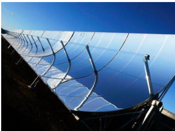
Figura 2. Concentrador Tipo Cilindro Parabólico. Fuente: (Briceño, 2011).
