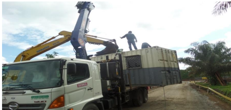
FIGURA 17: ACCIDENTES DE LOS TRABAJADORES DE LA CONSTRUCCION
