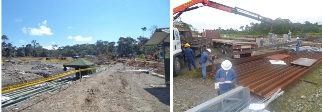
FIGURA 15: LOS EQUIPOS Y HERRAMIENTAS PARA LA CONSTRUCCIÓN DE UNA PLATAFORMA PARA EXPLOTACIÓN DE PETRÓLEO
