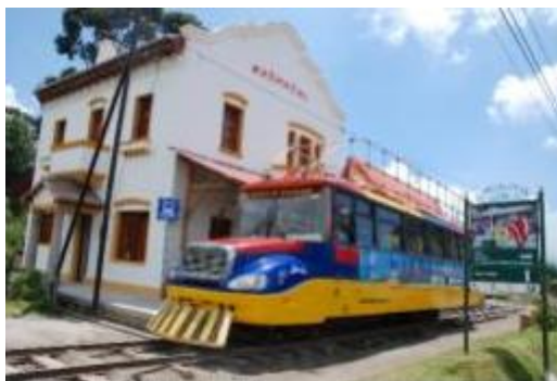
Figura 15. Estación del Tren
