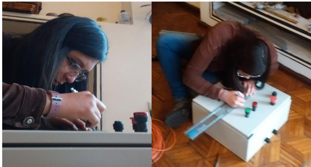
Figura 40 Colocación de elementos en la puerta del armario eléctrico
