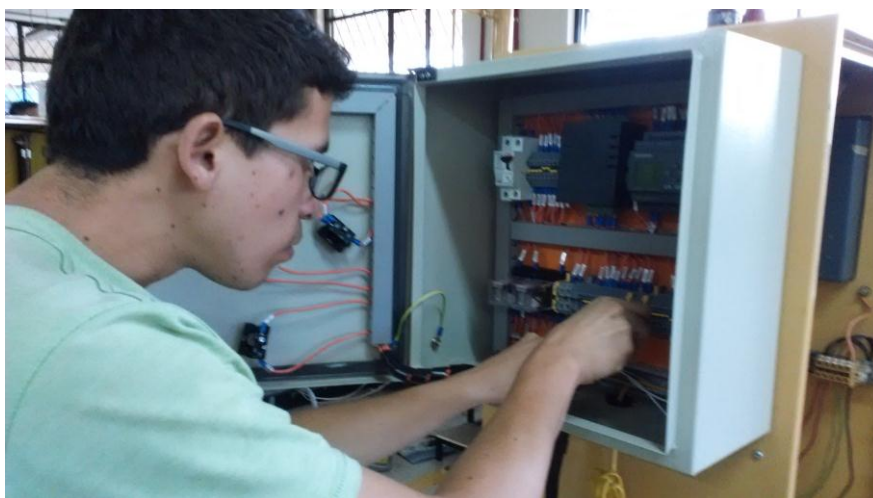
Figura 44 Colocación Armario eléctrico en el Banco de Pruebas
