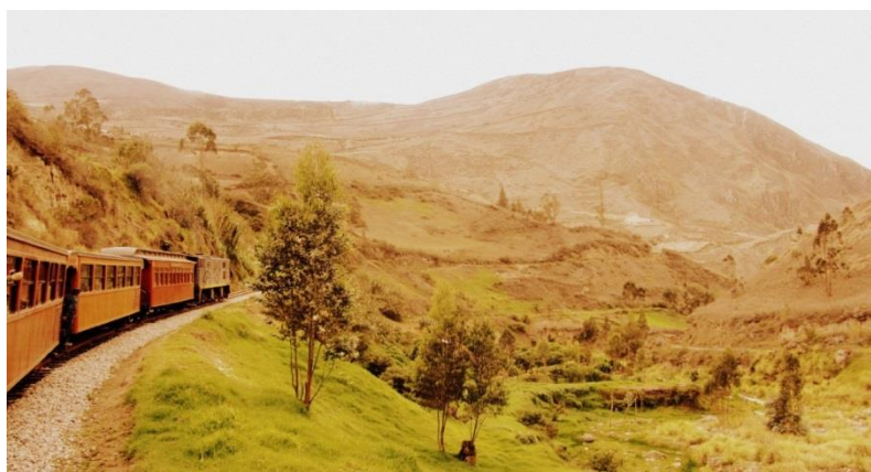
Figura 1 Reconstrucción de la vía Férrea Tramo Alausí-Palmira
