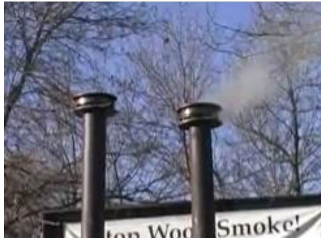
Figura 18. Chimenea de un sistema de combustión doble.
