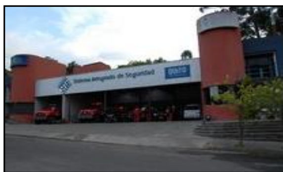
Figura 38 Estación de Bomberos N°11 El Tingo
