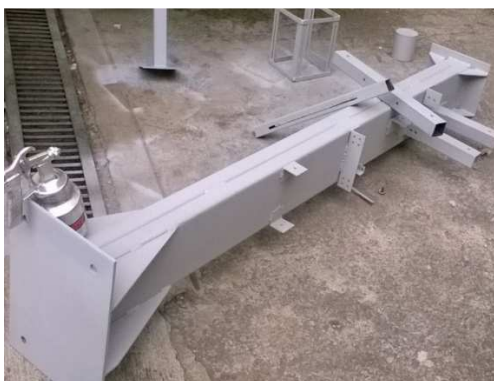
Figura 87. Aplicación de la capa 1 en la columna
