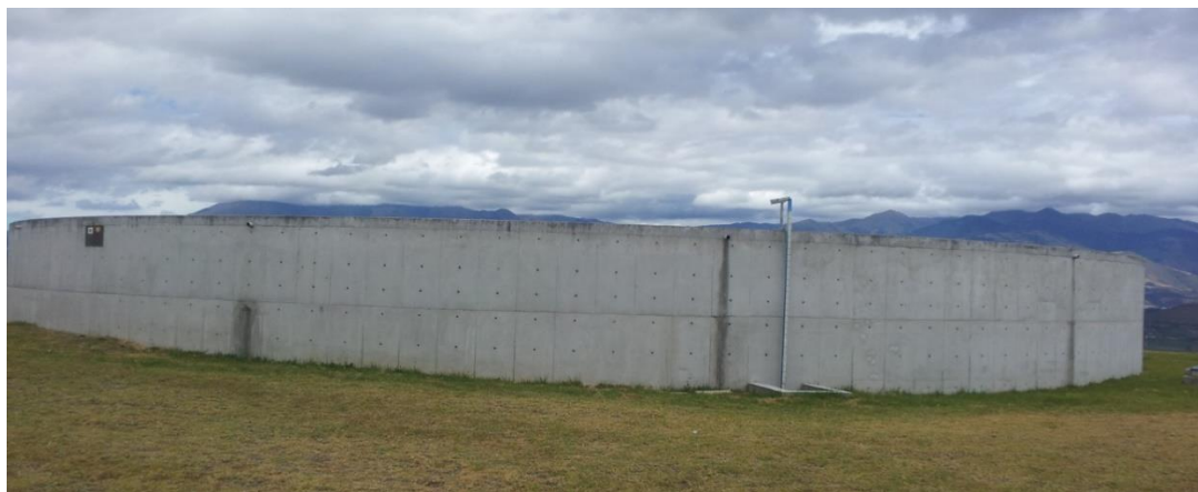
Figura 5. Tanque de almacenamiento 2500 m 3 de la estación de reserva
