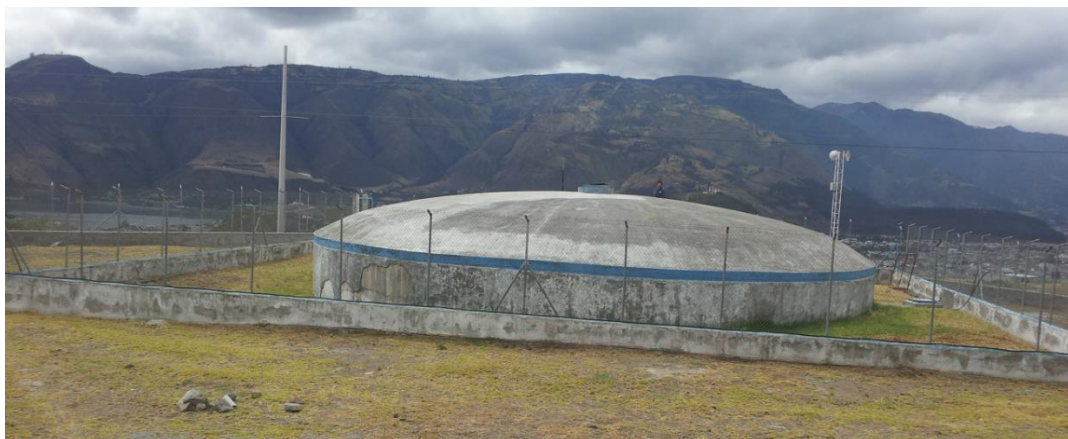
Figura 4. Tanque de 1000\text{ m}^3 de la estación de reserva
