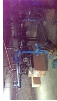
Cuarto de calderos, tanques de condensado y sistema de distribución, se debe considerar que ciertas partes del sistema de vapor y agua caliente fueron sustituidas en el año 2009, sin embargo aún existen equipos antiguos como bien se pueden observar en las fotografías abajo expuestas. Todos los equipos que operan con vapor tanto en el área de cocina, lavandería y suministro central tienen una operación promedio de 12 horas diarias.
