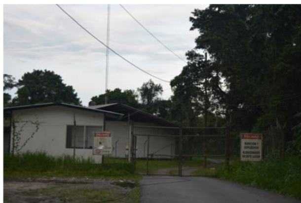
Figura 47: Área de almacenamiento de explosivos.
