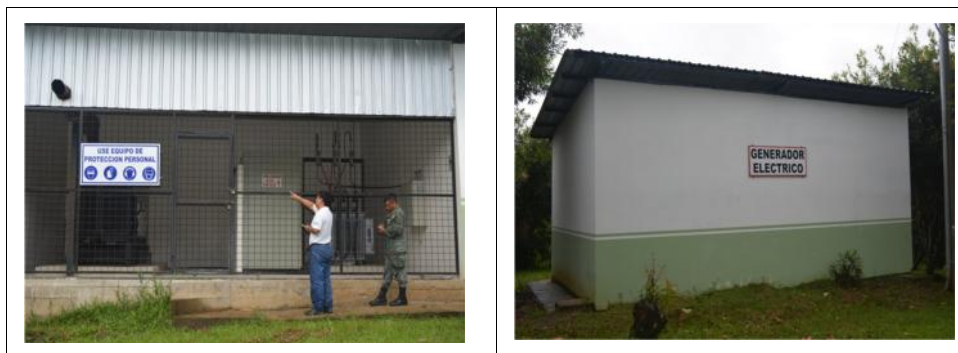
Figura 45: Área del generador eléctrico.
