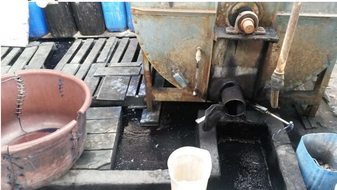
Descarga de aguas residuales a la alcantarilla
