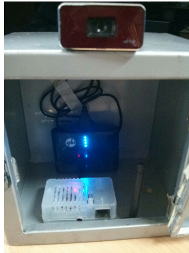
Figura 62: Caja metálica con los dispositivos para las pruebas de funcionamiento.
