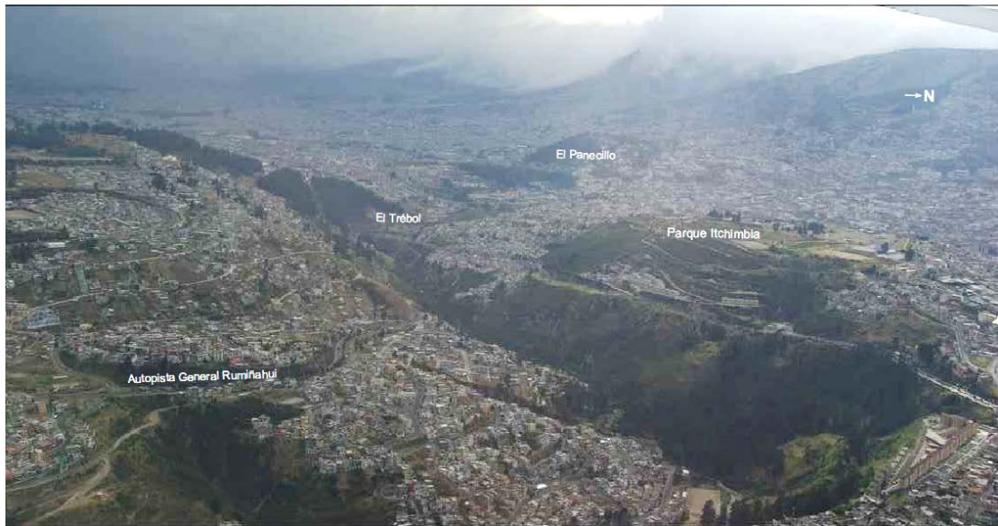
Figura 6: Segmento Puengasí atravesado por el río Machángara, Centro de Quito. Fuente: (www.skyscrapercity.com).
