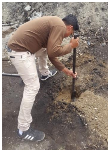
Figura 5. Construcción de calicata
