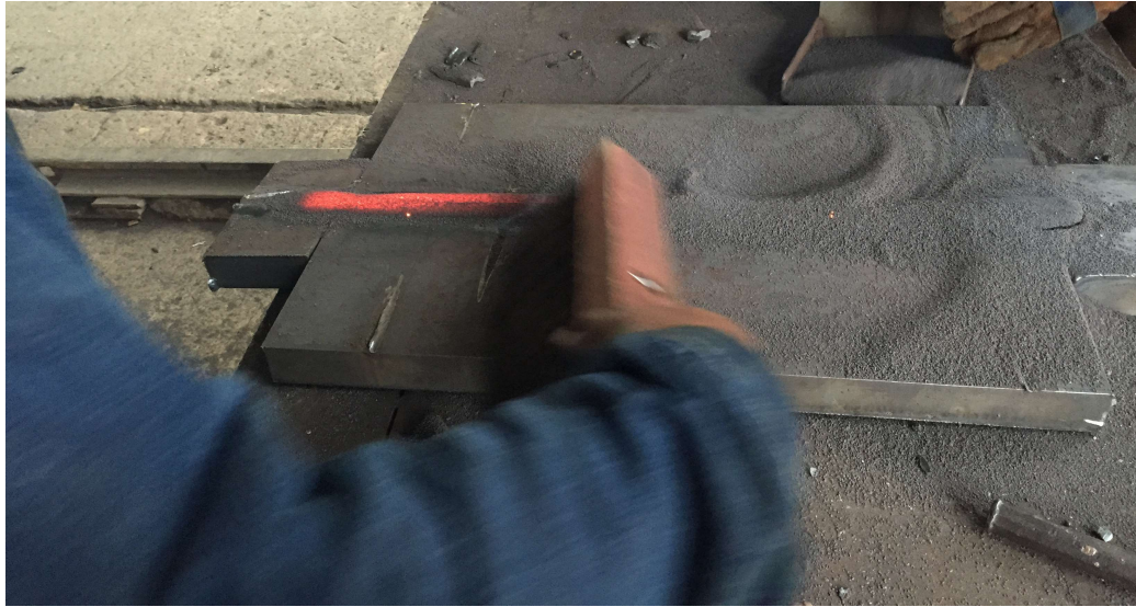
Fotografía 1 Calificación de la Soldadura
