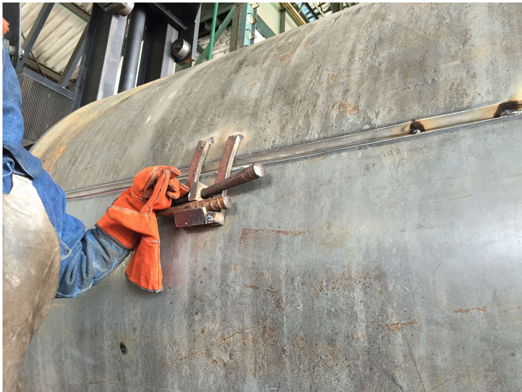
Fotografía 5 Refuerzos en Soldadura del Cuerpo del Auto Tanque
