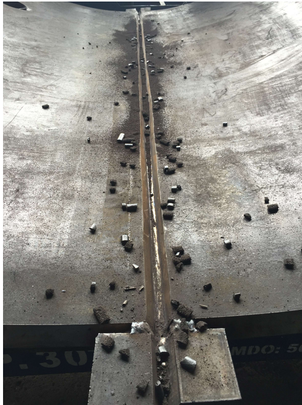
Fotografía 7 Soldadura de Raíz en el Cuerpo del Auto Tanque
