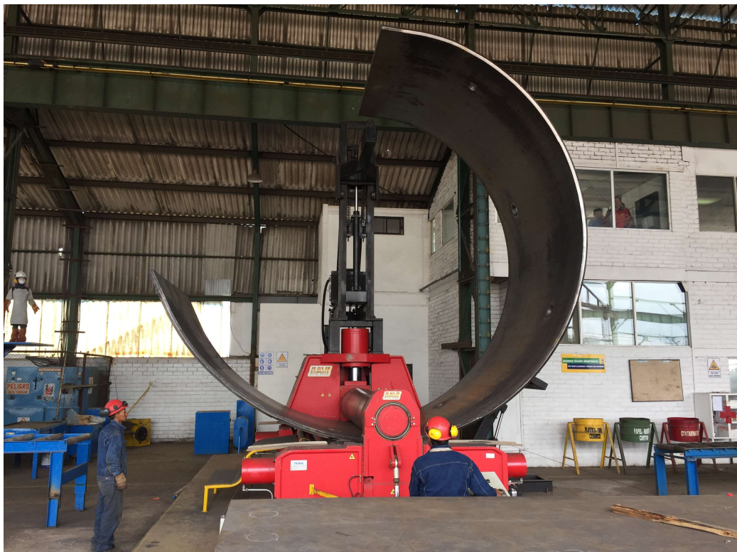
Fotografía 4 Conformación del Cuerpo del Auto Tanque
