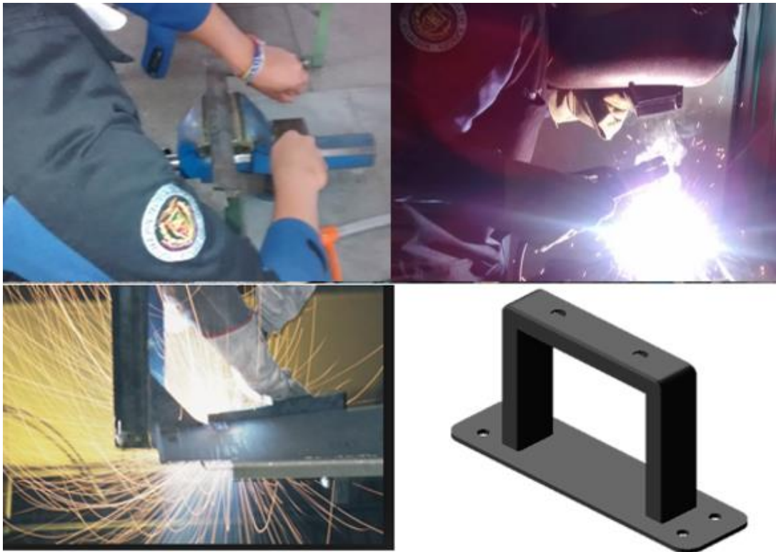
Figura 101. Proceso de mecanización de estructuras
