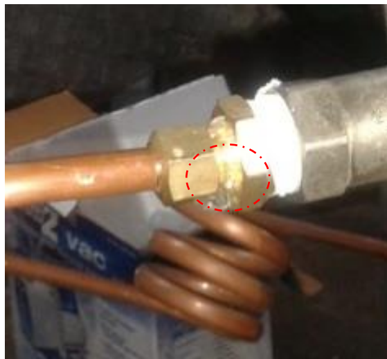
Figura 26: Agua jabonosa en conexiones
