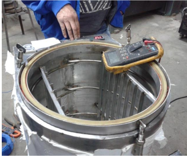
Figura 23: Pruebas eléctricas finales
