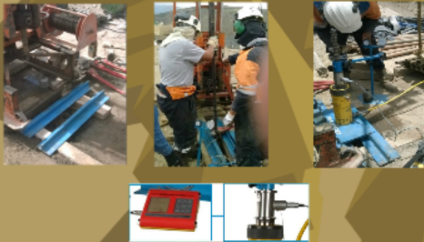
Instalación del equipo
