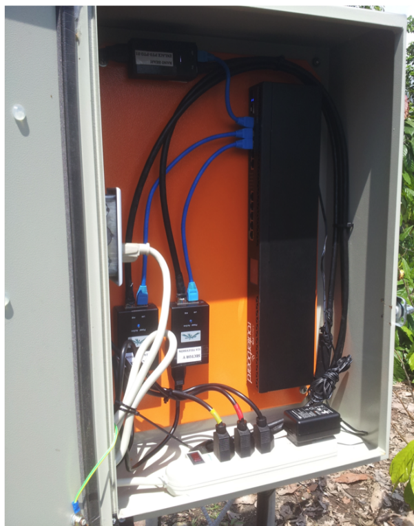
Figura 5.6: Instalación equipos en Estación Base.
