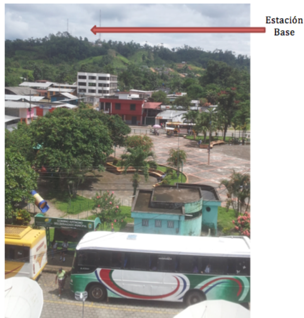
Figura 5.9: Panorama del Enlace Headend-Estación Base.
