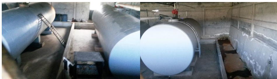
Figura 47. Separación de tanques y presencia de cunetas de contención Fuente: Sánchez B., Villamarín V.; 21/10/2015
