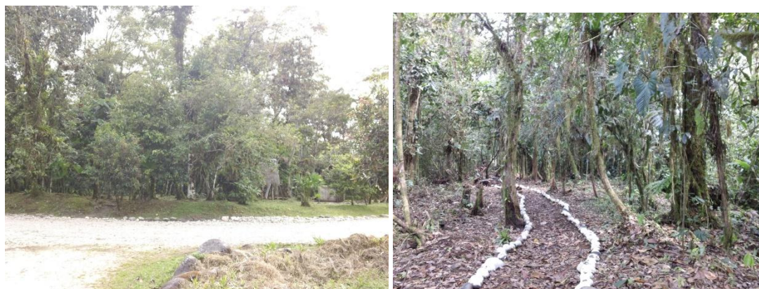
Figura 61. Construcción de senderos para el ecoparque Fuente: Sánchez B., Villamarín V.; 21/10/2015
