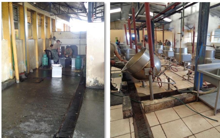
Figura 41. Mala ubicación de tanques de GLP/Mal manejo de residuos orgánicos Fuente: Sánchez B., Villamarín V.; 21/10/2015
