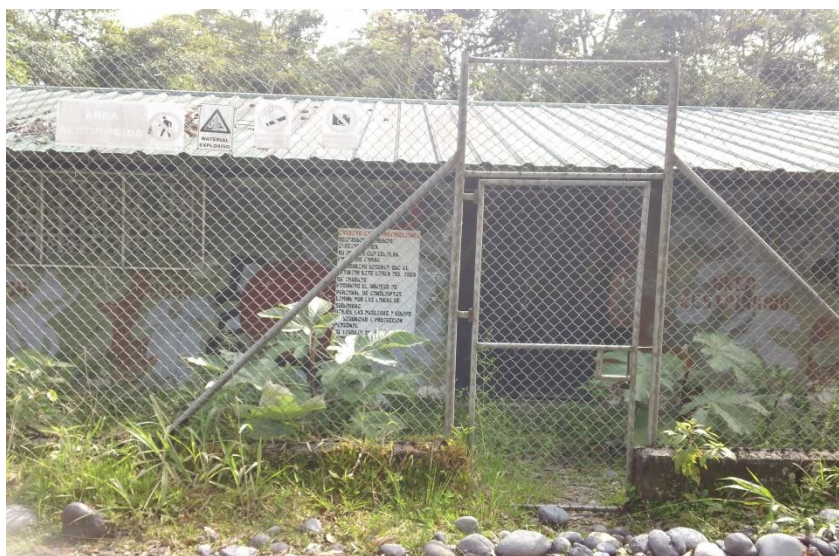
Figura 57. Bodega de Almacenamiento pequeña
