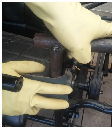
Figura 70 Lijado de la estructura
