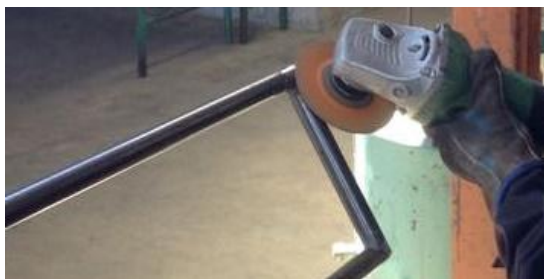
Figura 54 Pulido de las soldaduras
