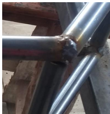
Figura 53 Soldadura en las uniones
