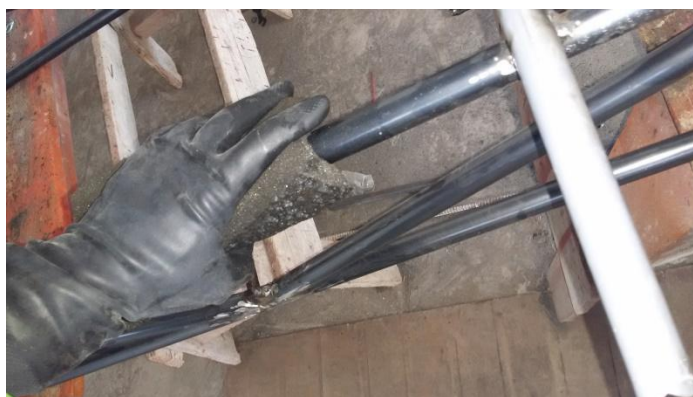
Figura 71 Limpieza de la estructura
