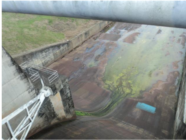
Figura 16. Vertedero embalse Daule - Peripa
