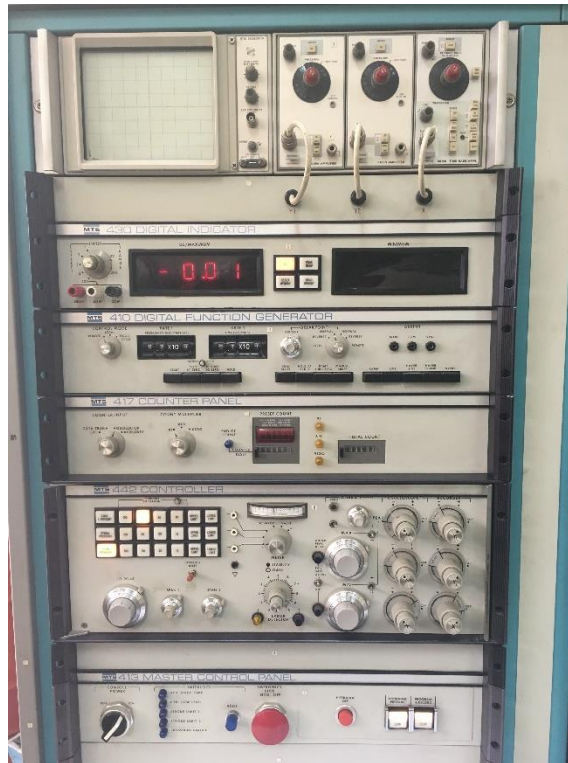
Figura 32: Panel de control de la Máquina universal de ensayos MTS.
