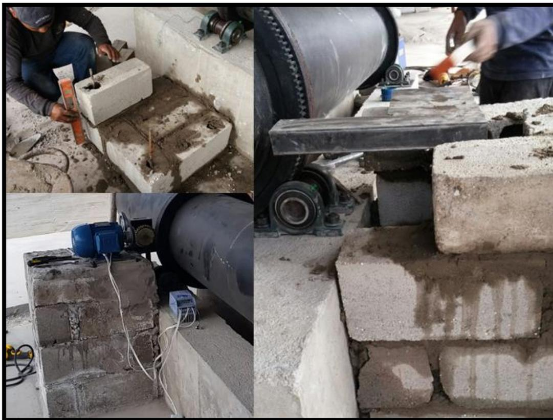
*Figura 70. Construcción de la base del motor.*
