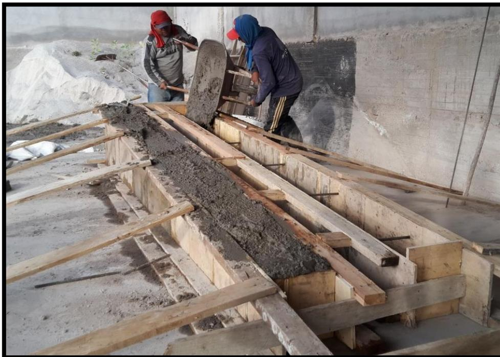
*Figura 64. Fundición de la losa.*
