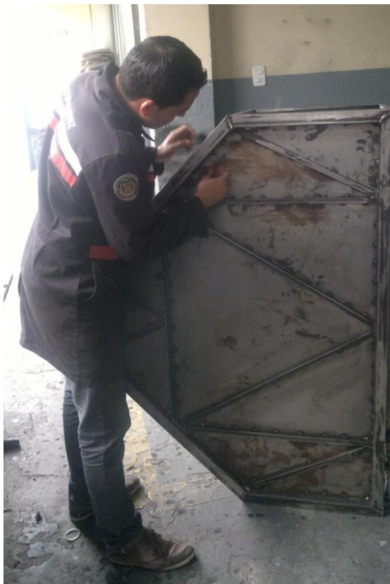
Figura 83: Preparación de las superficies del bastidor
