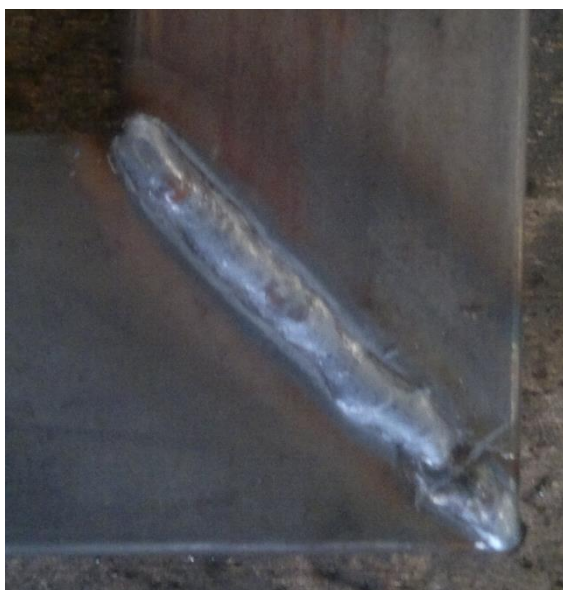
Figura 82: Cordón de soldadura de la base principal del bastidor
