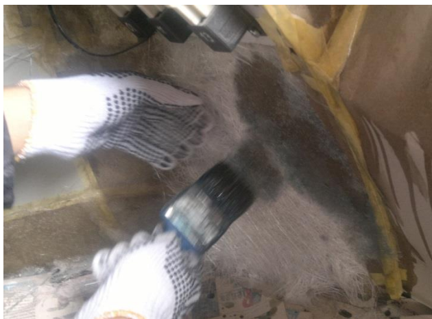
Figura 97: Colocación de la fibra de vidrio
