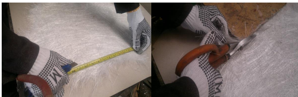
Figura 95: Corte de la Fibra de Vidrio
