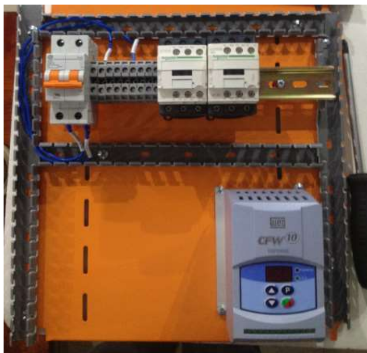
Figura 90: Montaje de canaletas, riel DIN y dispositivos electrónicos
