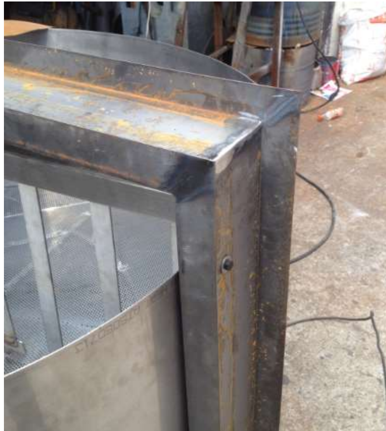
Figura 82: Esmerilado de soldadura de pórtico
