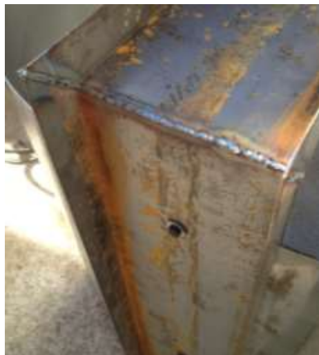
Figura 81: Soldadura de pórtico
