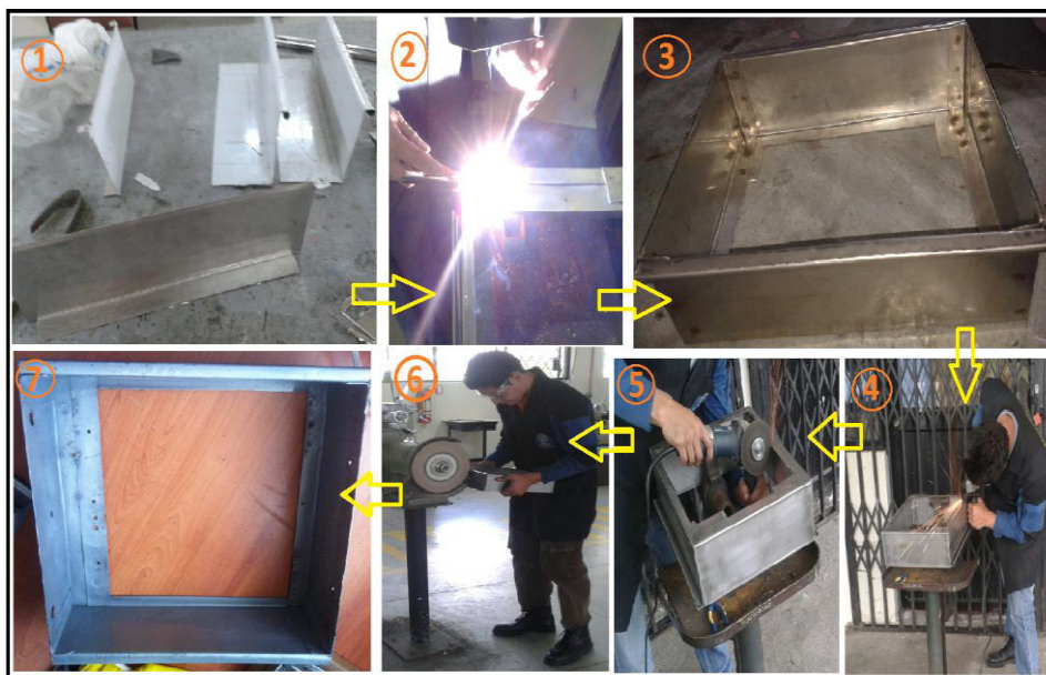
Figura 138.- Proceso de elaboración de la caja exterior
