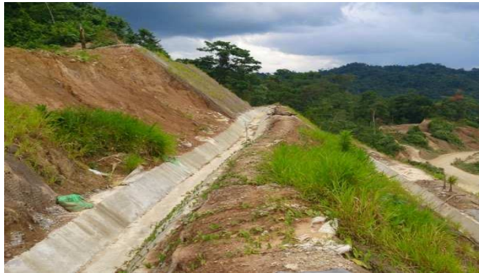
Figura 27 Zanja de drenaje en un talud
