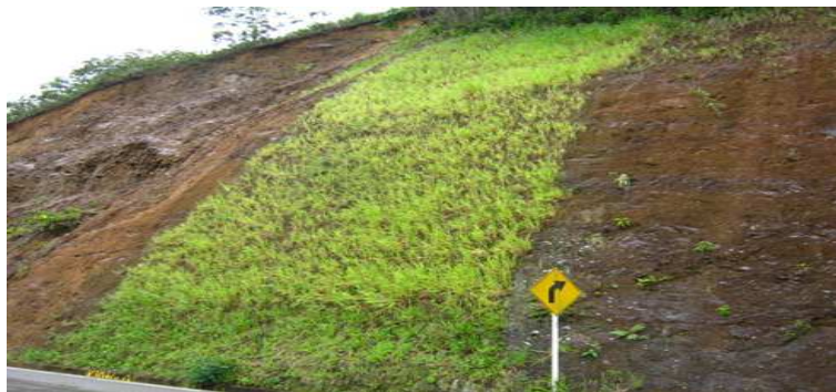
Figura 40 Recubrimiento vegetal en talud
