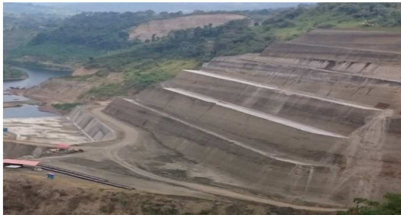
Figura 26 Berma en talud Multipropósito Chone
