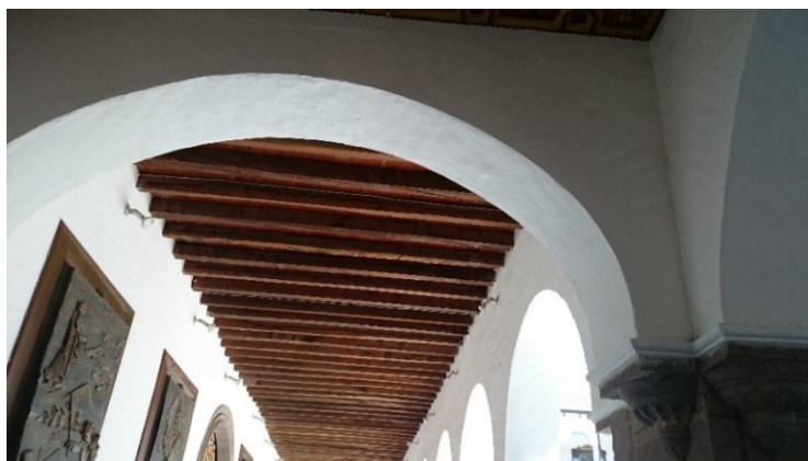
Figura 19: Vigas vistas desde interior
