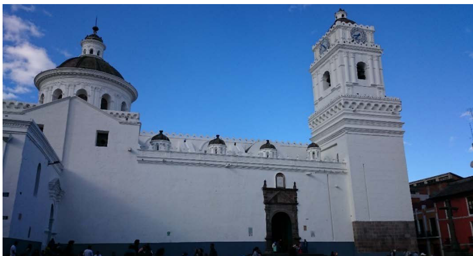
Figura 36: Fachada Iglesia La Merced – Calle Chile
