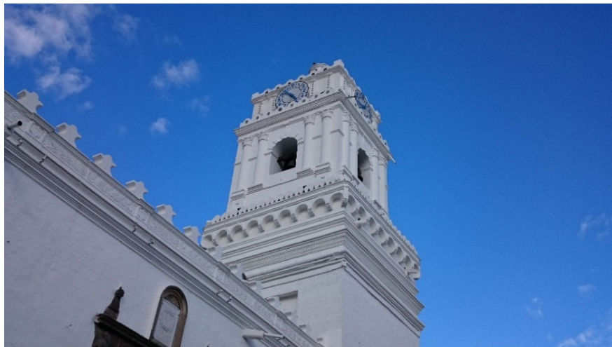
Figura 38: Exterior de la Torre
