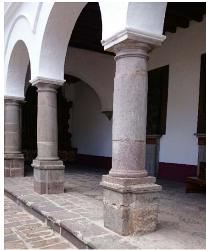
Figura 28: Pilares Piso Inferior
