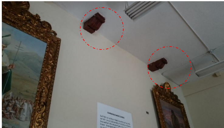
Figura 18: Vigas de madera embebidas en techo falso
