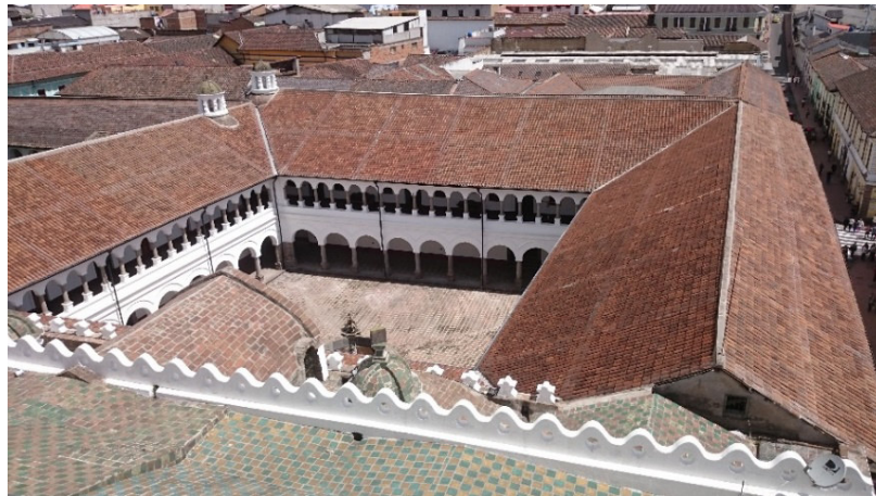
Figura 15: Cubiertas del Convento
