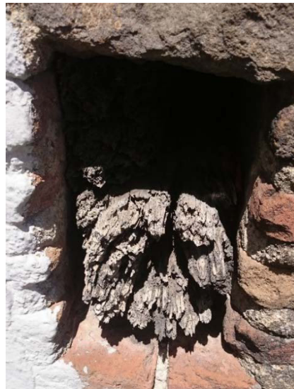
Figura 17: Vigas vistas desde el exterior
