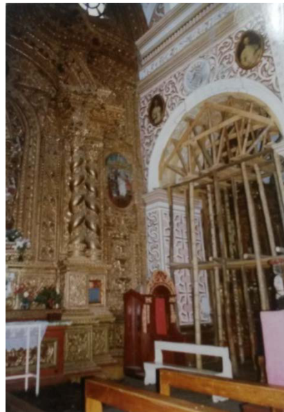
Figura 155: Arreglos en Arcos Interiores de Iglesia.
