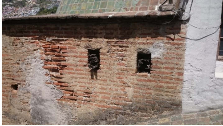
Figura 27: Muros de ladrillo
