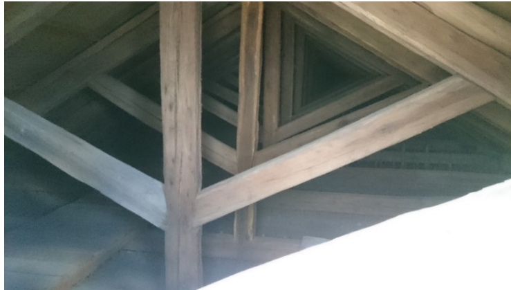
Figura 16: Interior de las Cubiertas
