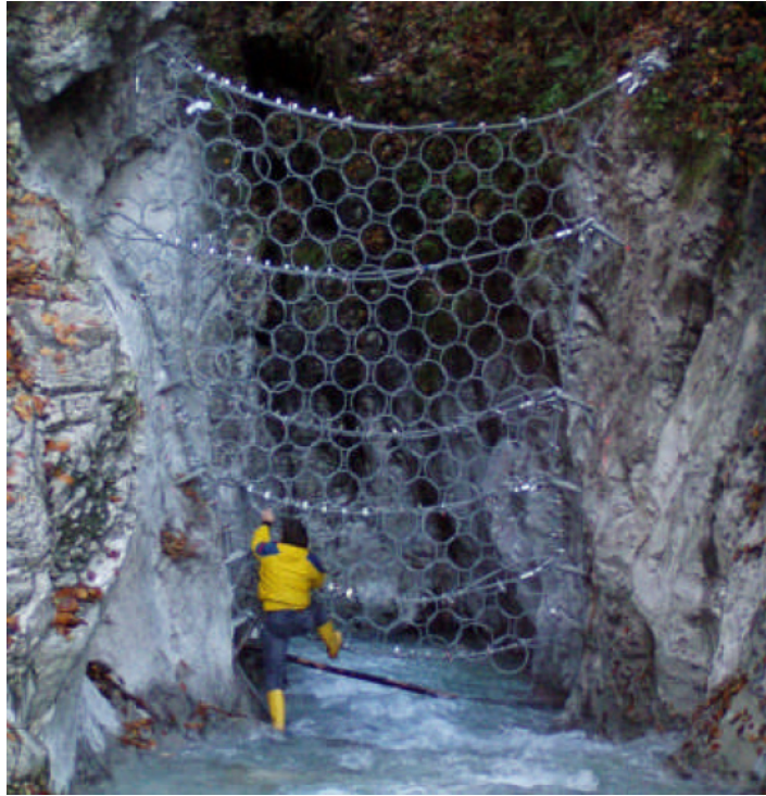
Figura 42. Malla flexible para retención de flujo de lodos en Goiserer Weissenbach, Austria.
