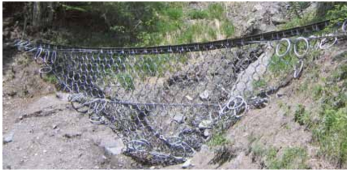
Figura 48. Disipador para el frenado del frente del flujo de detritos.
