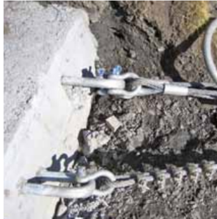
Figura 38. Anclaje del sistema.
