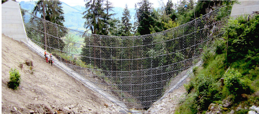
Figura 33. Barrera Flexible instalada en Berner Oberland.
