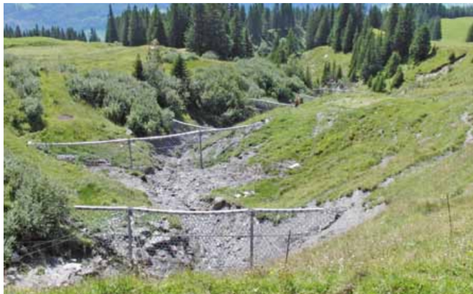
Figura 43. Barrera múltiple para retención de flujo de lodos. Milibach, Meiringen Suiza.
