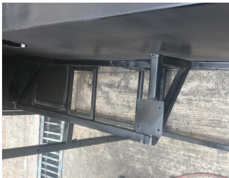
Figura 58: Montaje de los soportes para el sistema de refrigeración
