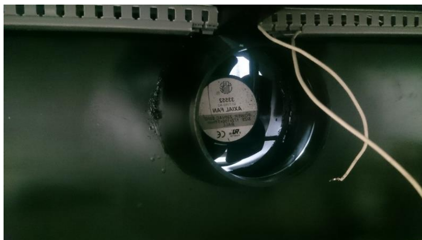
Figura 68: Pieza de PVC para adaptar la salida del ventilador axial a uno de los extremos del ducto.
