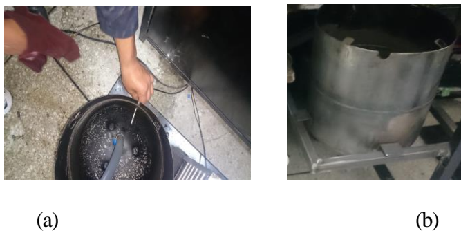
Figura 53: (a) Extracción del óxido de la superficie del contenedor (b) Lijado de la superficie del contenedor.
