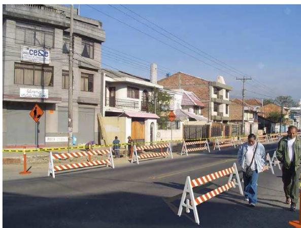
**Figura 82. Emplazamiento tipo de señales y dispositivos de seguridad: Doble sentido de circulación y dos carriles**
