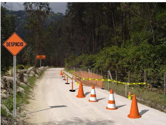
**Figura 85. Emplazamiento tipo de señales y dispositivos de seguridad: Doble sentido de circulación y un carril**
