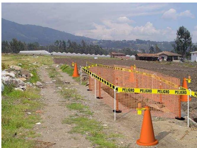
**Figura 84. Emplazamiento tipo de señales y dispositivos de seguridad: Señalización con malla en zonas rurales**
