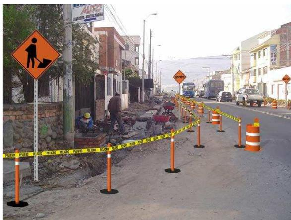
**Figura 83. Emplazamiento tipo de señales y dispositivos de seguridad: Aceras como áreas de trabajo**
