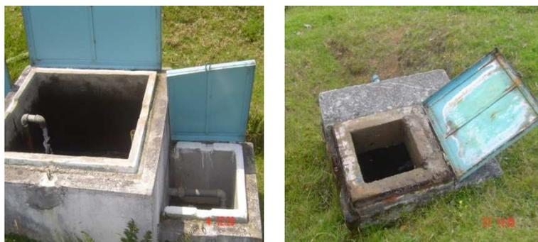
**Figura 9. Fotografías de tanques rompe presiones en la red de conducción**
