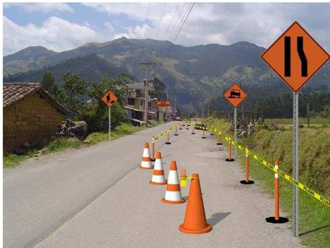
**Figura 81. Emplazamiento tipo de señales y dispositivos de seguridad: Vías urbanas**
