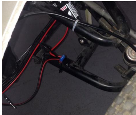
Figura No. 72. Sensor de Voltaje para las Celdas Instalado
