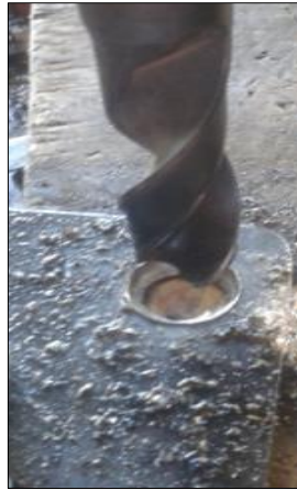
Figura 71.- Perforación de la placa
