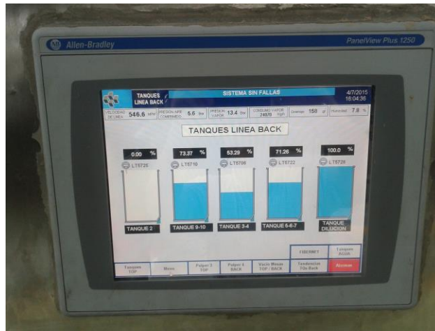
Figura 16. Foto de HMI 1ra línea de producción. Fuente: Comercializadora San Remigio
