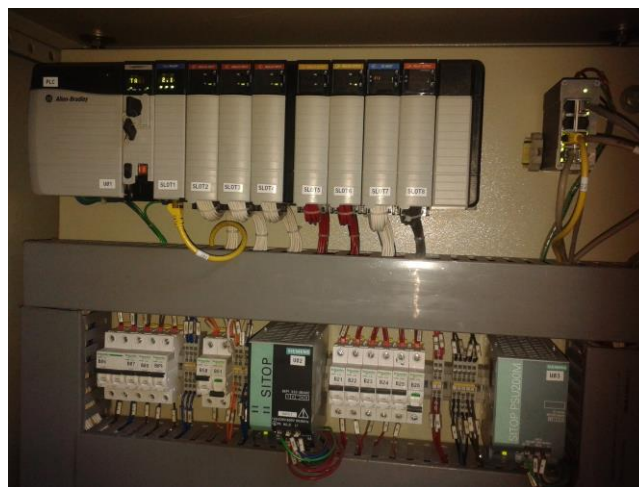
Figura 17. Foto de PLC principal 1ra línea de producción. Fuente: Comercializadora San Remigio
