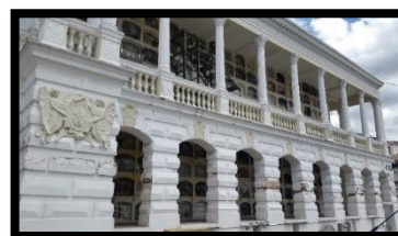
Figura 83 Pabellón 1. Autor: Autoras
