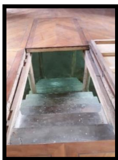
Figura 59 Ingreso criptas capilla de las Almas. Autor: Autoras
