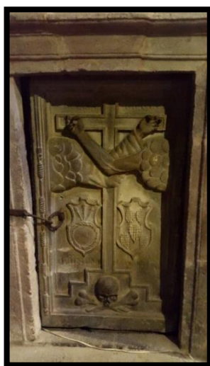
Figura 41 Puerta de piedra cripta.
