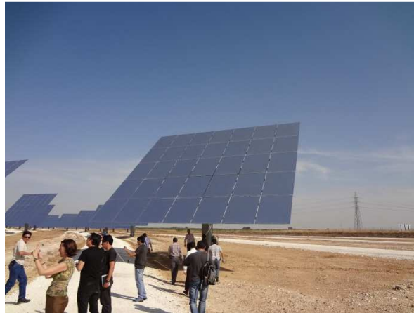
Figura 10: Helióstatos de la planta Gemasolar
