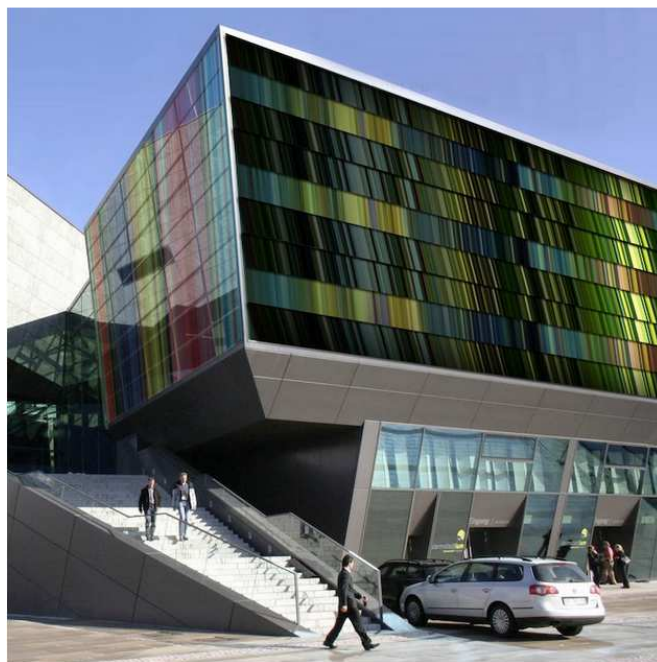
Figura 18: Vista de la fachada del proyecto Light Farm
